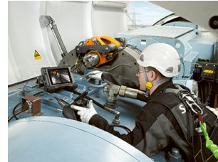
図1：ギアボックス内の検査
